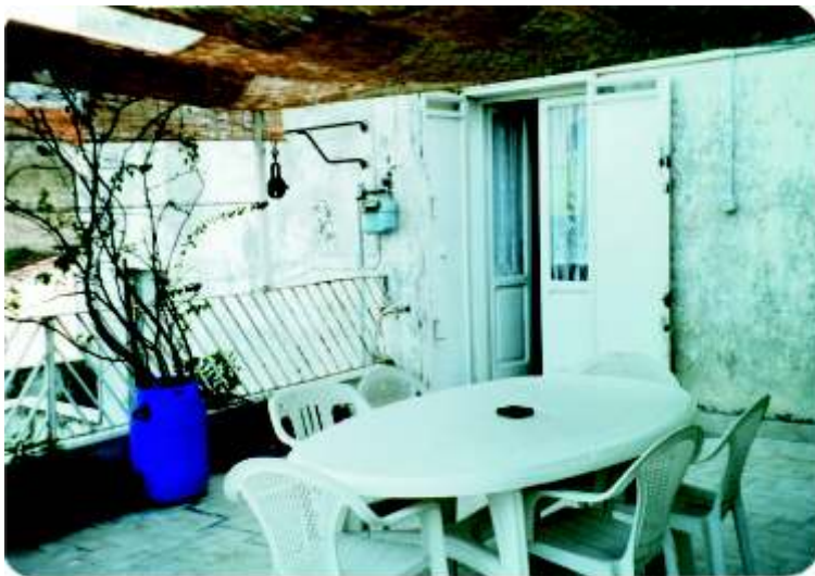
Il terrazzo della casa canonica prima del restauro
