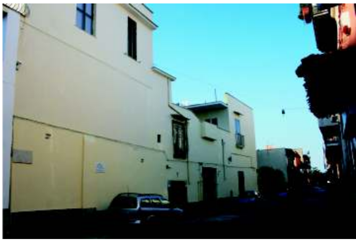
Casa canonica dopo il restauro
